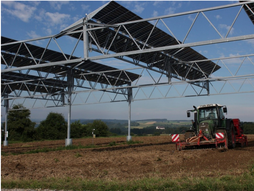
Abbildung 2: Agro-Photovoltaik Anlage der Hofgemeinschaft Heggelbach 14 . Landwirtschaftliche Produktion und Energieerzeugung am gleichen Ort schließen sich nicht gegenseitig aus.
